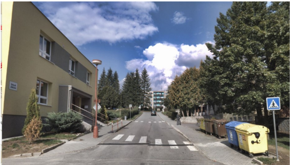
Obrázek 13 Nedostatečná ochrana chodců před ZŠ praktická, Velké Meziříčí Poštovní ulice
