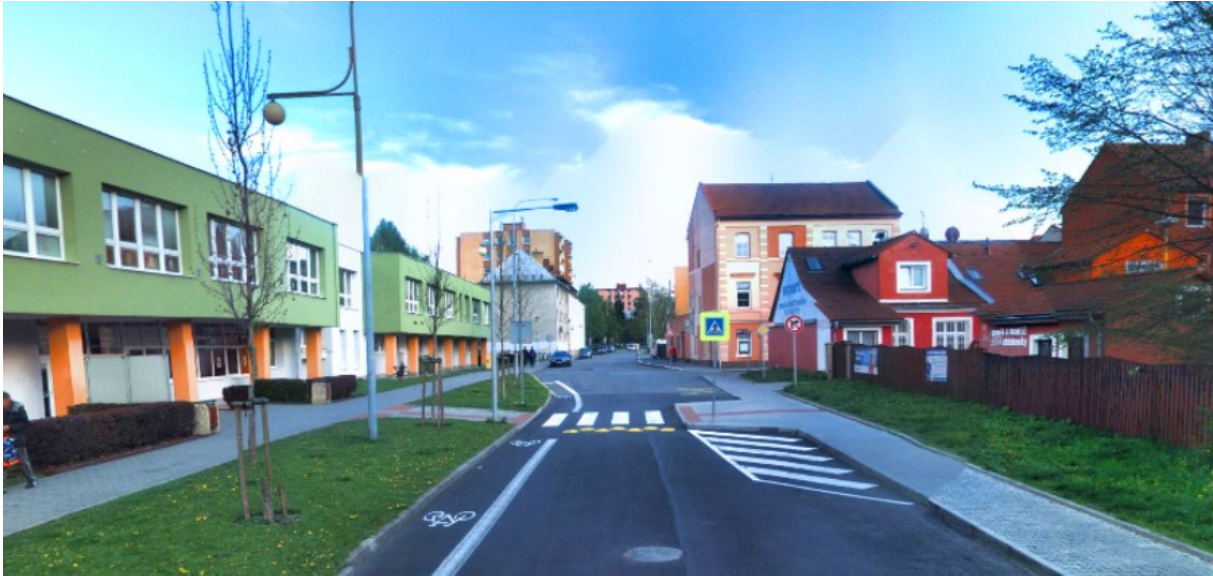
Obrázek 12 Vhodné řešení přechodu pro chodce před školou v zóně 30, příklad Komenského Nový Jičín
