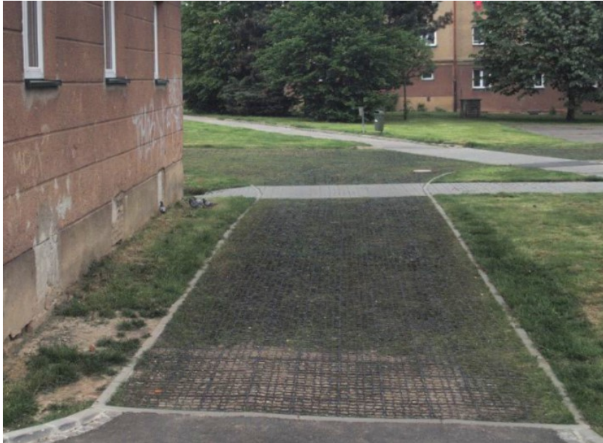
Obrázek 14 Příklad řešení parkování plastovými zatravnovacími rohožemi
